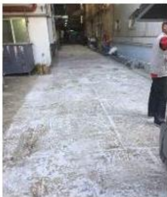
廠區地面防滑(依作業環境需求進行 PP 與 FRP 材質鋪設)
