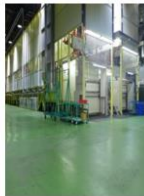
廠區地面防滑(依作業環境需求進行 PP 與 FRP 材質鋪設)
