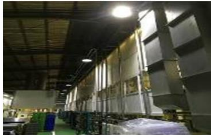
廠區照明(依照度需求及節電效能進行 LED 燈組更換)
