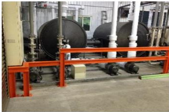
冷卻系統改中央控制冰水系統(節能與集中管理)
