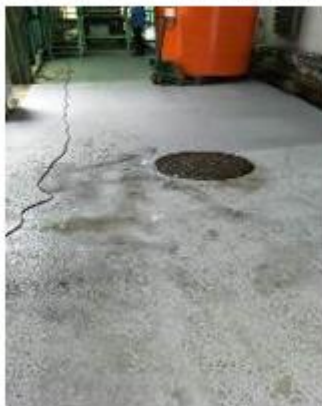
廠區地面防滑(依作業環境需求進行 PP 與 FRP 材質鋪設)
