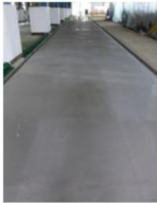
廠區地面防滑(依作業環境需求進行 PP 與 FRP 材質鋪設)
