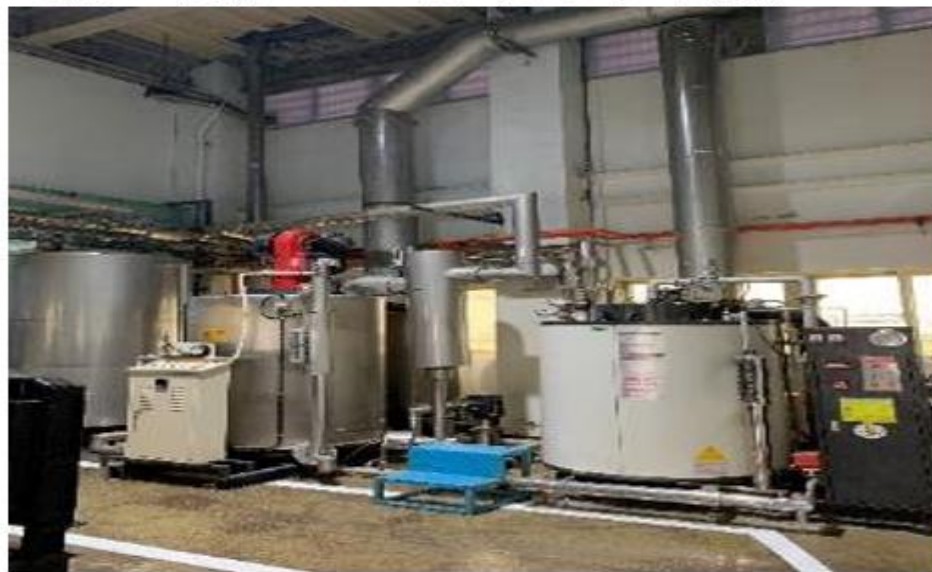
廠區重油鍋爐汰換(全面汰換為瓦斯鍋爐)
