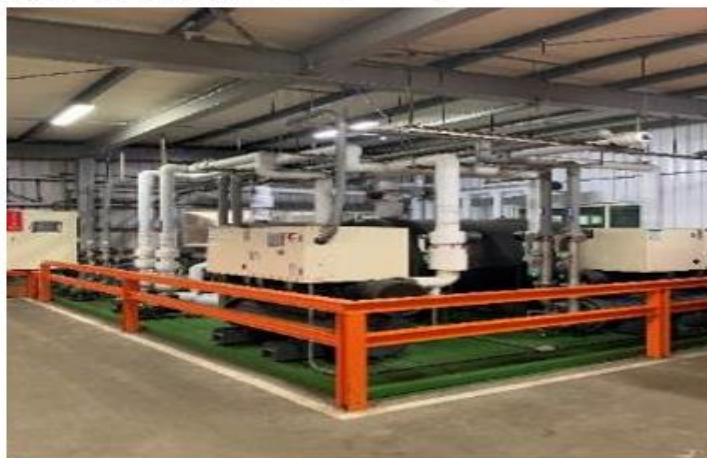
冷卻系統改中央控制冰水系統(節能與集中管理)
