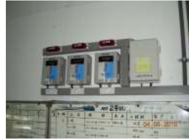
可燃性氣體偵測器設置範例
