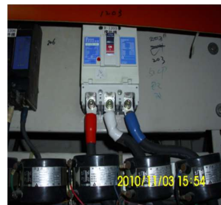
台灣配電盤配線顏色規定： R(紅)、S(白)、T(藍)(三相)
