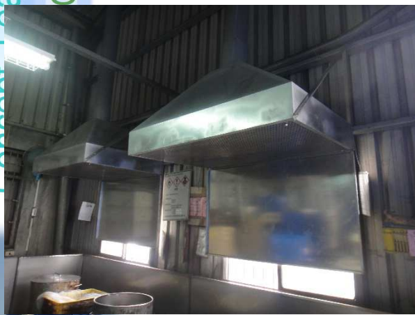
增加抽風設備改善有機溶劑逸散濃度
