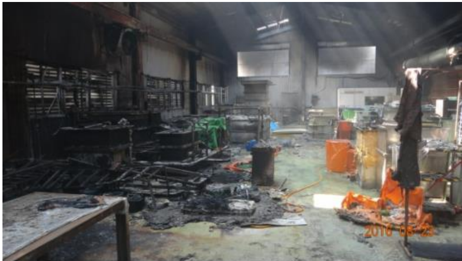
某科技公司加熱槽電線走火造成廠房燒毀
