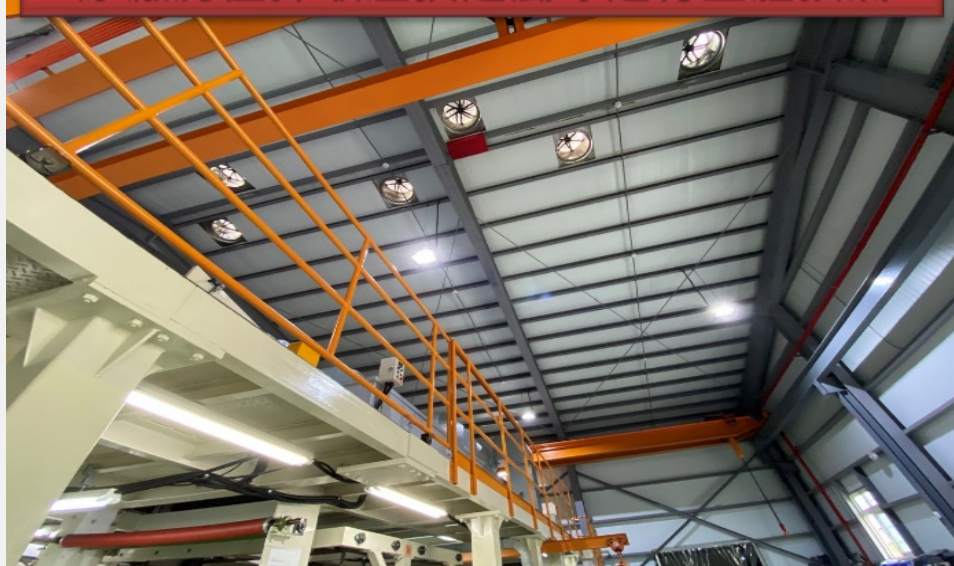
原廠房僅採取屋頂通風球進行整體換氣
