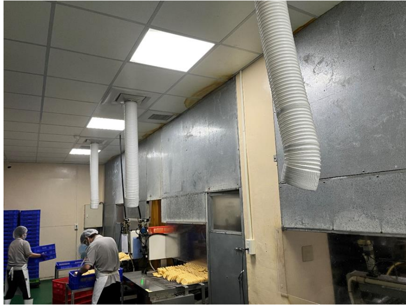
圖 6 進階輔導-增設風管將冷氣送至人員作業位置
