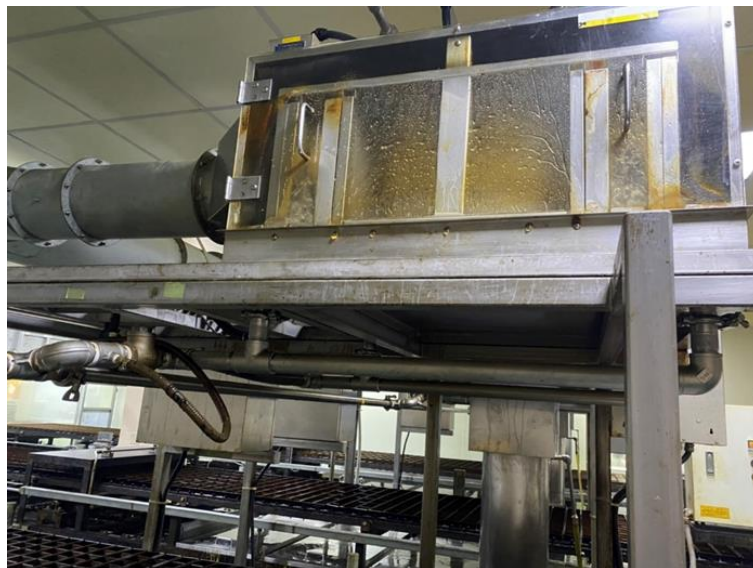
圖 1 進階輔導-油炸槽上方局部排氣系統水洗設備
