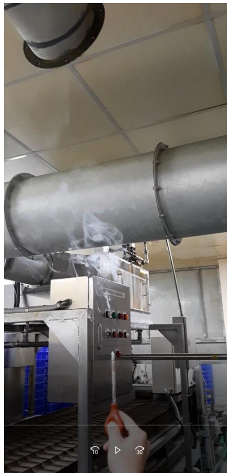
圖 3 進階輔導-油炸作業區局部排氣設備捕集效果不佳
