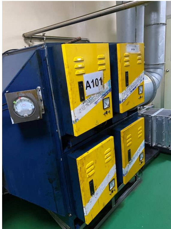
圖 2 進階輔導-靜電集塵機處理油煙
