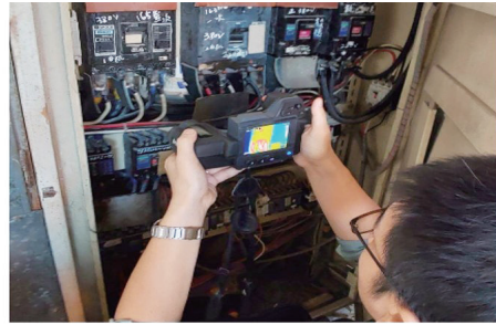
現場檢測情形
