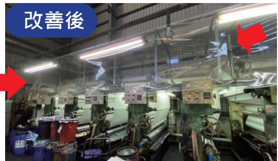
改善後 印花機上方增透明遮簾（氣罩）、局排系統
