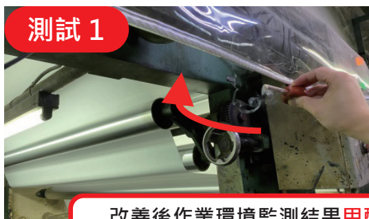
測試 1 透明遮簾（氣罩）邊緣測試 煙流吸入氣罩情形良好
