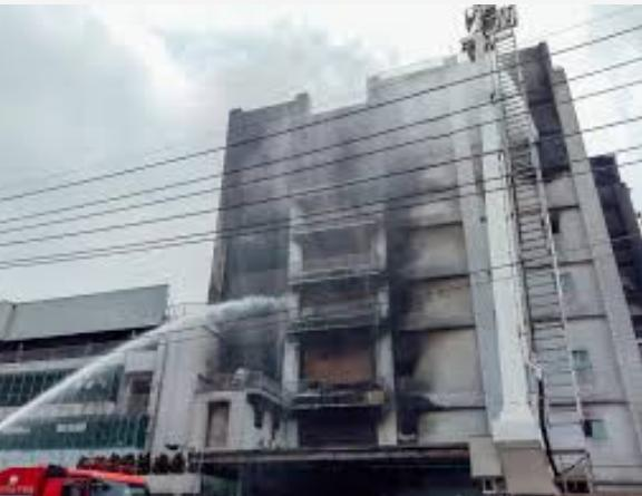
2018年4月28日桃園市某PCB廠發生火災，造成8人重大死傷事故。釀災主要原因與製程排氣管線延燒有重大關聯；回顧歷年產業的火災，大部分均與製程排氣風管材質的延燒特性有關。
